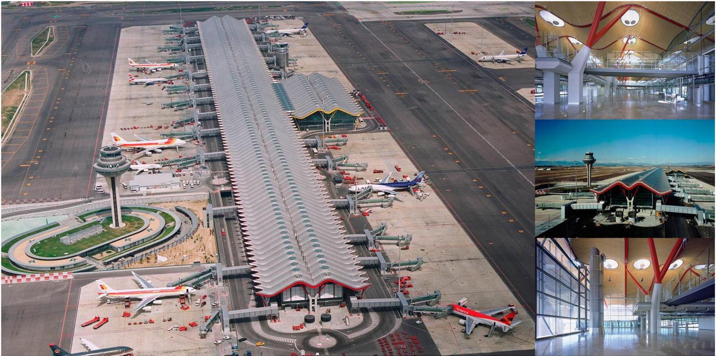
El edificio Satélite tiene 70.000,00 m<sup>2</sup>, distribuidos en una zona central, de 144,00 m x 180,00 m de dimensiones en planta, y en dos diques laterales, de 396,00 m x 54,00 m. Dependiendo de las zonas, estos diques tienen hasta tres niveles bajo rasante y dos niveles sobre rasante. Cabe destacar el hecho peculiar de que uno de los diques tiene que apoyarse sobre el túnel del soterramiento de la M-111.
